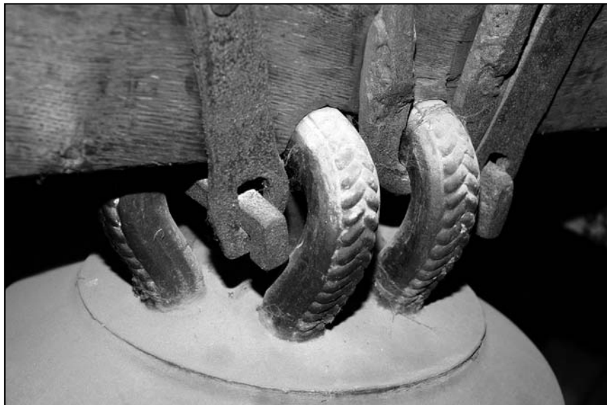
Zvon mistra Petra z Mýta z roku 1476 v Dubicku. Detail uchycení závěsné koruny zdobené pletencem v dubové hlavě pomocí skob a závěsných pásů. Zvon byl v 60. letech včetně technického příslušenství šetrně zrestaurován.
